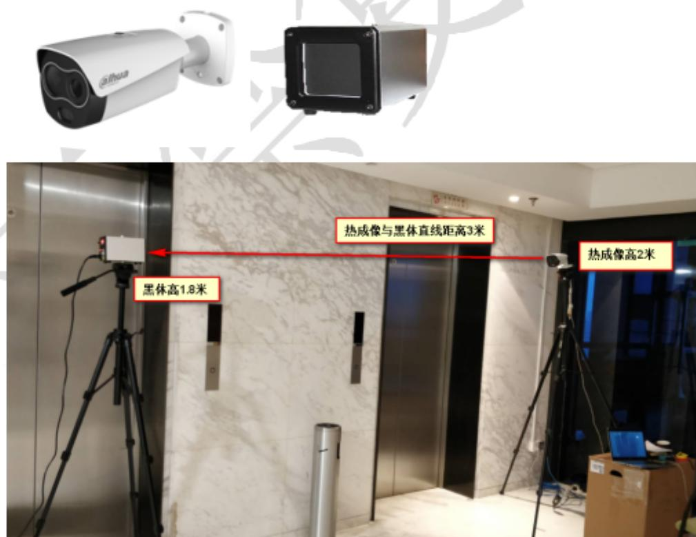
图 4.1-3 热成像相机三脚架安装示意图
